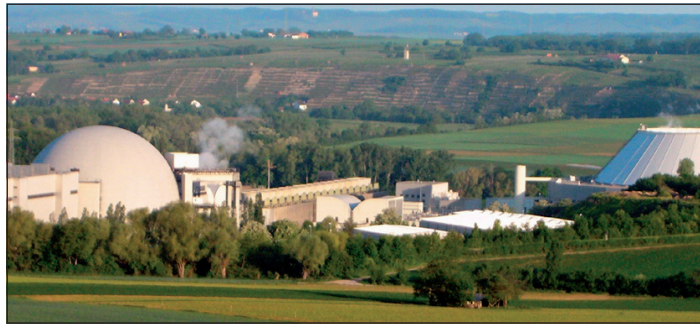
Atomkraftwerk Neckarwestheim, Hybridkühlturm und Zellenkühler
